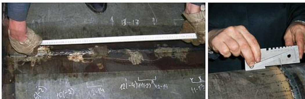
Рис.1.Проверка сварного шва
