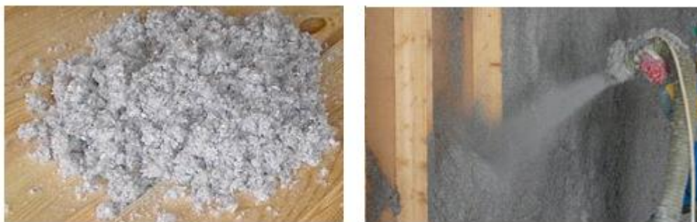
Рис.2.84. Общий вид теплоизоляции из эковаты и метод напыления ее с использованием специальной надувной установки
