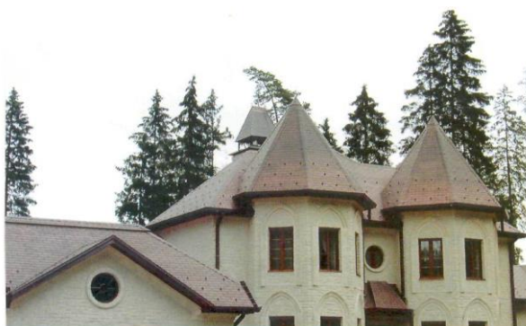
Рис.2.134. Устройство кровли из гибкой битумной черепицы «шинглас»
