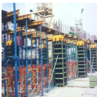
Рис.2.57. Общий вид щитовой опалубки монтажно-технологической оснастки для бетонирования колонн
