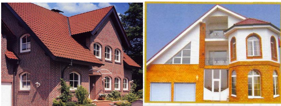
Рис. 2.126. Фасад здания, отделанный облицовочным кирпичом
