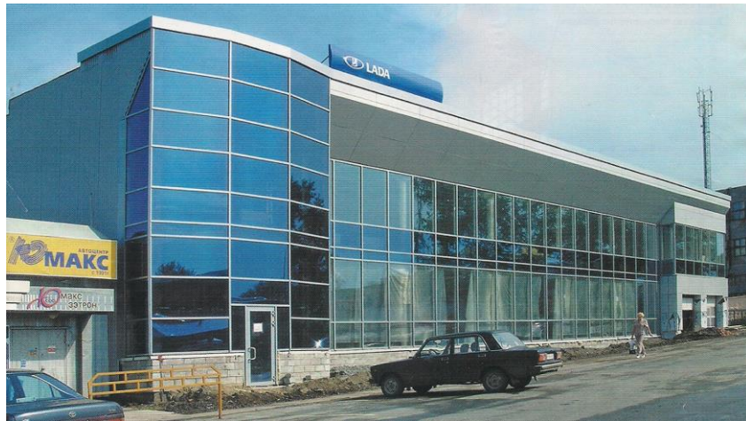
Рис.2.124. Отделка фасада здания сэндвич - панелями
