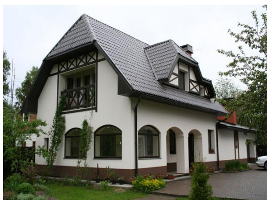
Рис. 2.115. Наружная штукатурка фасада на акриловом вяжущем
