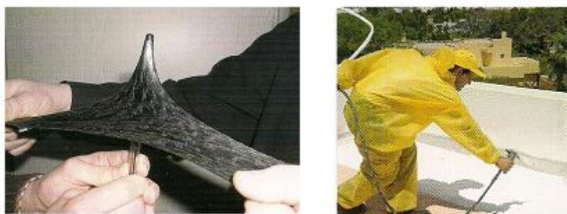
Рис.4.54. Общий вид «жидкой резины» и нанесение ее с помощью краскопульта
