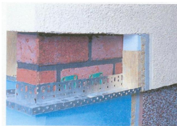
Рис. 3.6. Крепление теплоизоляционного слоя на нижней части стены
