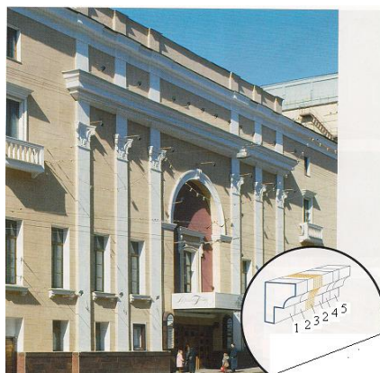
Рис. 3.10. Элементы для декоративной отделки зданий: 1 - декоративный элемент; 2- армирующий состав; 3 - армирующая стеклосетка; 4 - выравнивающий состав под окраску; 5 - фасадная краска
