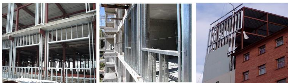
Рис.2.82. Устройство каркаса из термопрофилей при надстройке этажа
