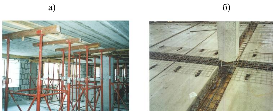
Рис.2.54. Поддерживающая монтажно-технологическая оснастка: из телескопических стоек (а) и многопустотные плиты, уложенные в проектное положение (б) с арматурой ригелей
