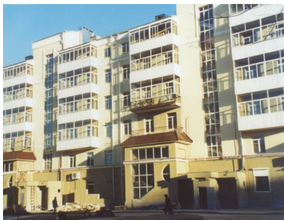
Рис. 3.25. Остекление балконов с использованием металлического каркаса
