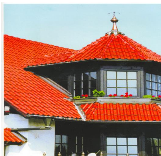
Рис. 2.129. Кровля из металлочерепицы
